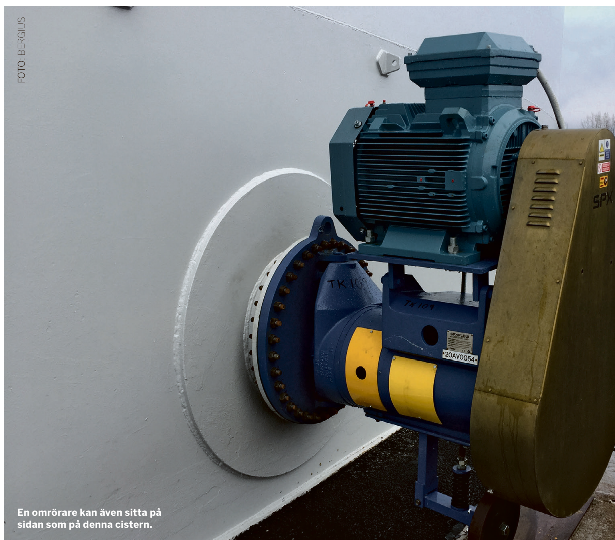
Omrörare för lakning av malmslurry.
